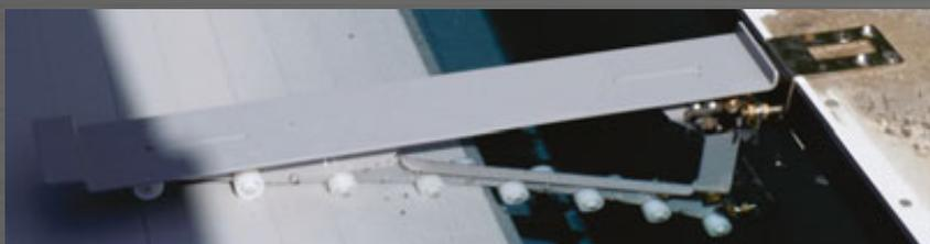
Ces équerres en aluminium anodisé noire ont été spécialement conçues pour les piscines dont le niveau d'eau est à 50 mm de l'arase du bassin (piscines équipées de skimmer miroir, page 28), et sont disposées tous les mètres dans la largeur du bassin. Elles permettent de supprimer avantageusement la poutre, et supportent les caillebotis et le poids d'un homme de 80 kg.
